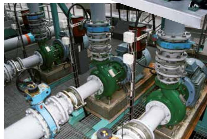
Ansimag – teflonbelagd magnetpump.
